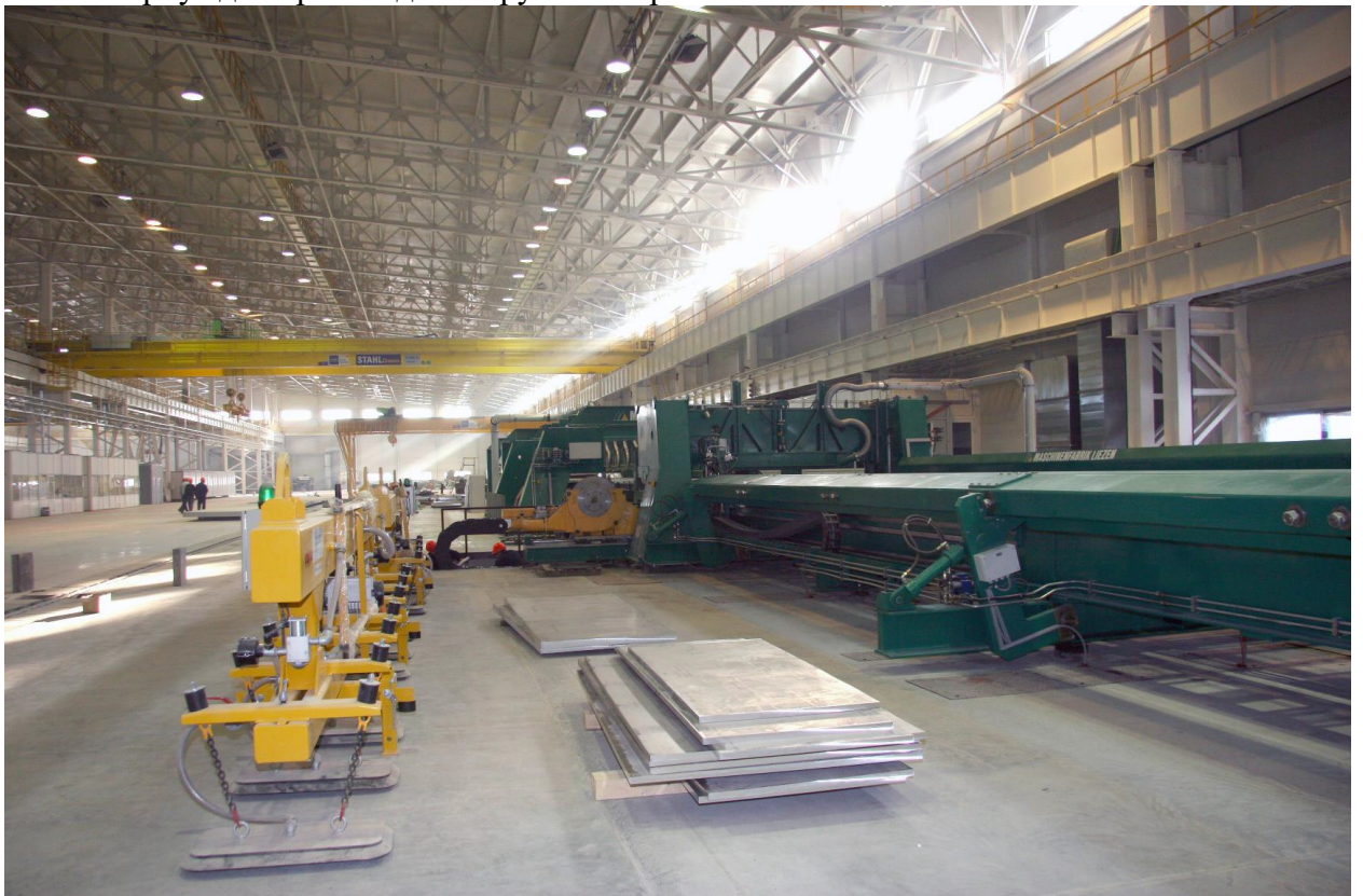
Фото. Корпус для производства крупногабаритных плит»
