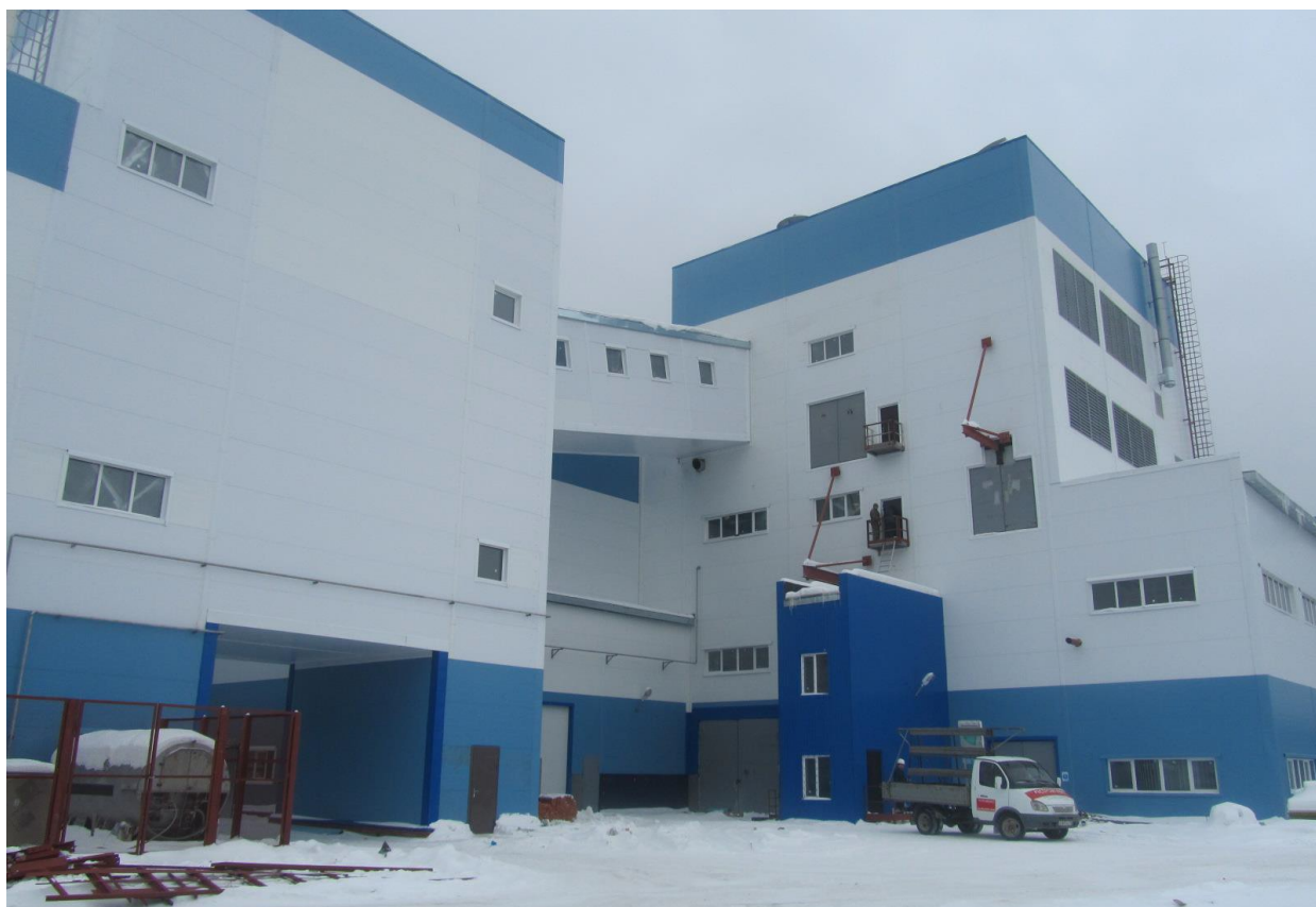
Фото. Завод по производству теплоизоляционных минераловатных материалов. 2-я технологическая линия. г. Асбест».
