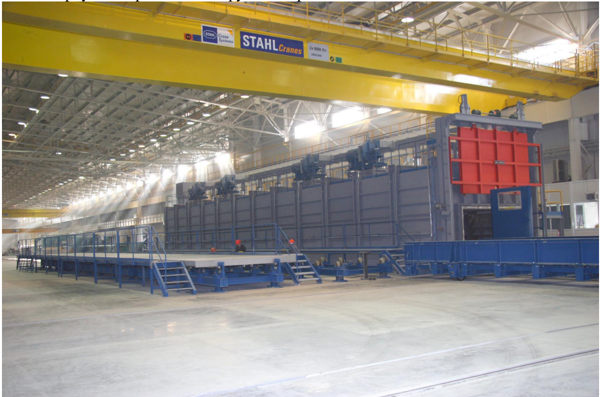
Фото. Корпус для производства крупногабаритных плит»
